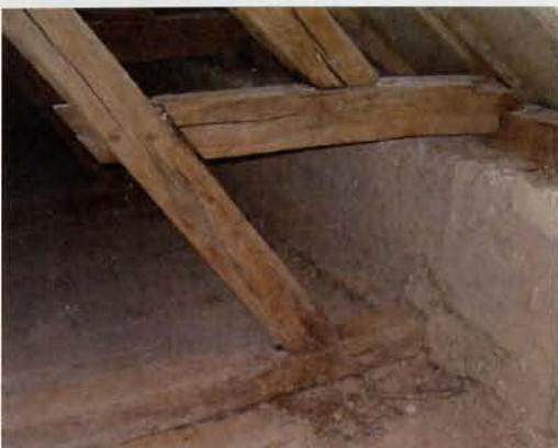
*Le pourrissement de l'extrémité inférieure de cette jambe de force assemblée à l'entrait bas semble indiquer un désordre de toiture avec cheminement de l'eau le long des bois.*
