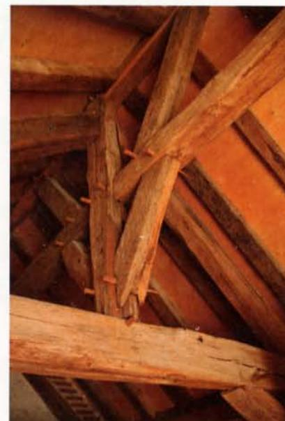
Vue détaillée d'une charpente avec sous-faîtage raccordé, d'une part à la panne faîtière, d'autre part à la partie basse du poinçon.
