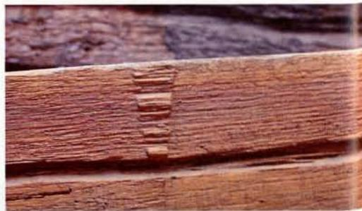
Deux traces d'outils de taille : à gauche, traces de taille à la hache, à droite, trace d'arrachement du bois sur une poutre sciée à la scie de long.
