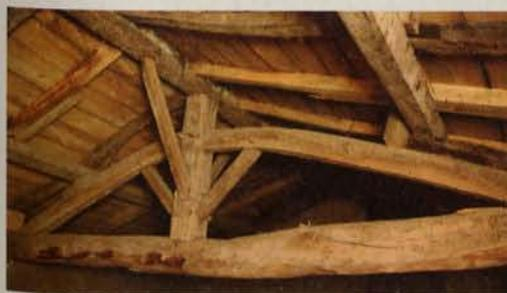
Dans une charpente en place, un charpentier sait toujours reconnaître la position qu'occupait la pièce de bois dans l'arbre (dans le pied, dans la tête), mise en œuvre en fonction des nœuds et des fibres visibles, mais aussi en fonction des sections. Ici, l'entrait de cette ferme, dont les extrémités sont de sections différentes, indique bien la tête et le pied de l'arbre mis en œuvre.
