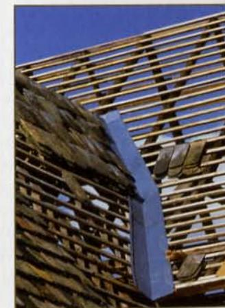
Raccordement de deux pans de toiture formant noue (ici recouvert d'un noquet en zinc)
