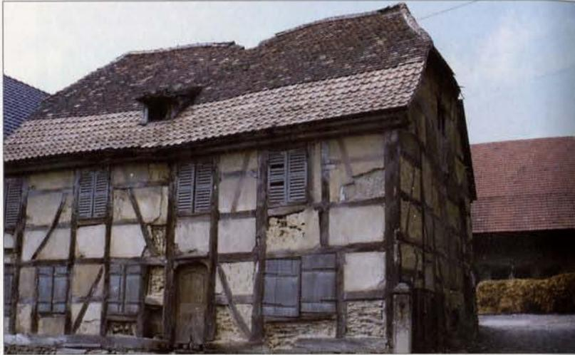
On intervient ici sur une panne faîtière dont seule la partie centrale est détériorée. Dans cet exemple, le désordre a entraîné la dégradation d'une partie de la toiture.
