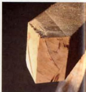
*Une scie circulaire permet au charpentier de tailler l'about de la pièce qui s'assemblera à d'autres éléments de charpente.*
