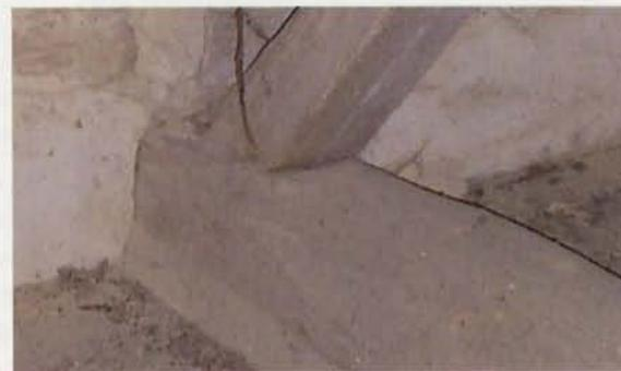
Une probable dégradation de l'extrémité de cet entrait, prise dans une maçonnerie qui l'empêche de respirer, met à terme en danger la stabilité de la ferme.
