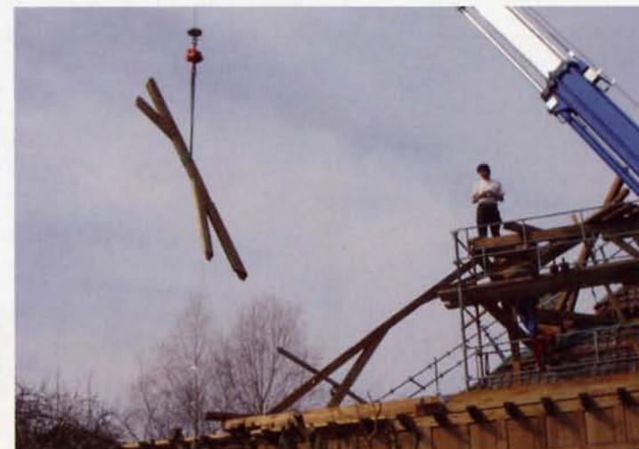
*Selon le type de chantier, la charpente est levée manuellement ou mécaniquement. Ici, c'est un bras télescopique qui facilite la manœuvre.*
