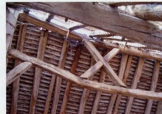
*Le fléchissement important du sous-faitage n'a pas entraîné sa rupture mais a provoqué la dislocation de l'assemblage dans le poinçon de la ferme, à gauche.*
