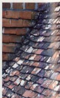
Le raccordement d'une toiture aux surfaces verticales que sont souches de cheminée ou jouées de lucarne est une zone particulièrement fragile.
