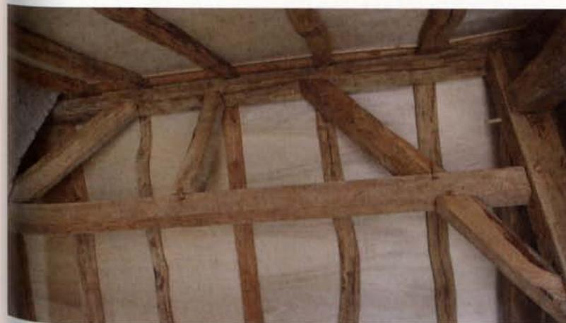
Le contreventement longitudinal est assuré par un sous-faîtage assemblé au poinçon et soutenu par un aisselier. Il est, par ailleurs, relié au faîtage par deux liens et un potelet.
