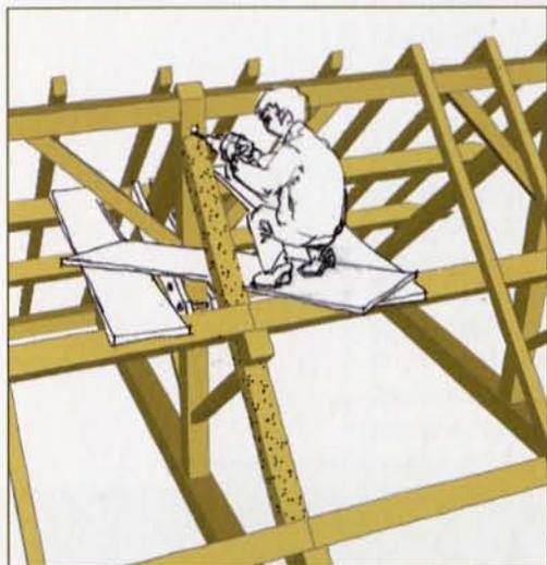
1. On travaille généralement en sous-œuvre, c'est-à-dire sans avoir à dégarnir le toit. On retire simplement les chevrons sur 2 m de part et d'autre de la ferme où l'on intervient.
