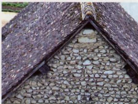
Dans une toiture à deux pans, il s'agit de protéger de l'action directe de l'humidité la charpente apparente; dans le cas d'une croupe, c'est le solin des arêtes qui est surveillé.
